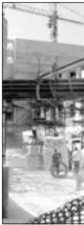
Un cantiere edile
