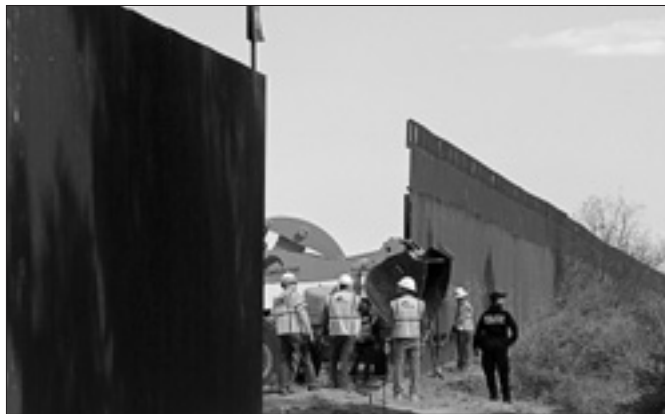
I lavori di rafforzamento del muro al confine tra Messico e Stati Uniti (Reuters)
